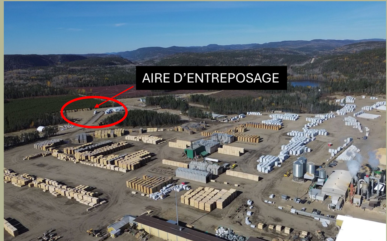
Vue aérienne Site de Boisaco
