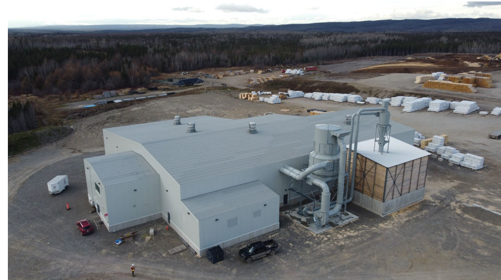
Vue aérienne du nouveau site de rabotage de Scierie St-Elzéar
