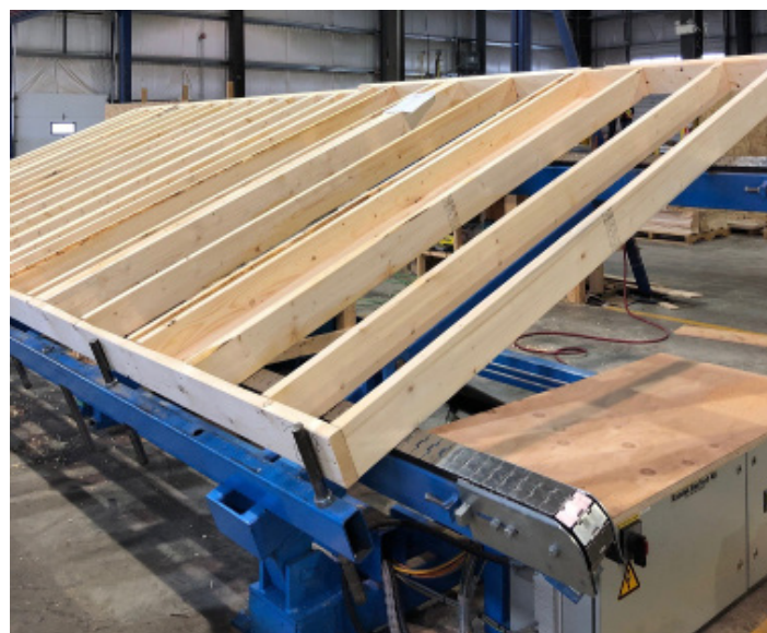
Production de panneaux muraux préfabriqués
